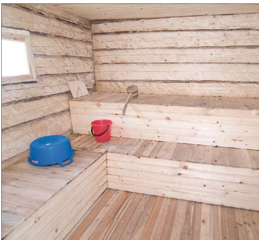
Первым проектом была сауна, обшитая вагонкой, струганной на РН260.
